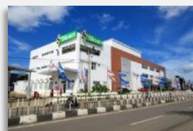
Siloam Hospitals Baubau & Lippo Plaza Baubau
